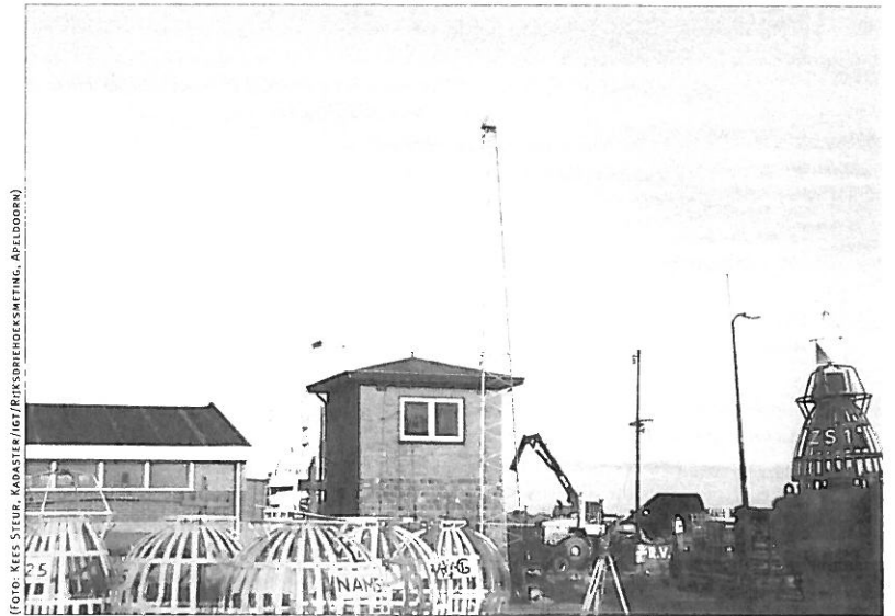
Station van het AGRS.NL (Actief GPS-referentiesysteem Nederland) op het gelijdeemeststation van Rijkswaterstaat op West-Terschelling. Om met GPS met centimeter-nauwkeurigheid te kunnen meten, is in Nederland een speciaal meetnet neergezet, bestaande uit vijf referentiestationen, elk met een hoogwaardige GPS-ontvanger.
